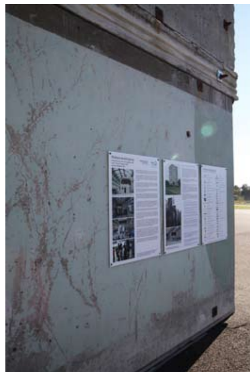
Informationstafeln am Gebäude der Plattenvereinigung
