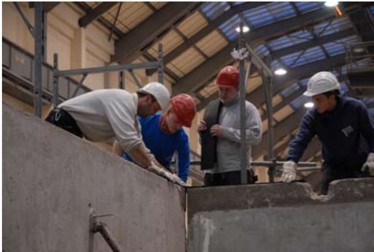
Vorbereitungen für die Auflagerung der Zwischendecke
