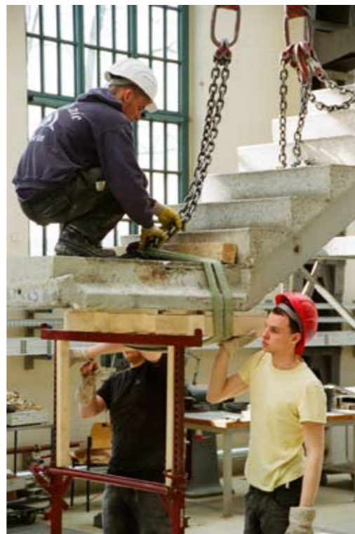
Montage der Treppenelemente
