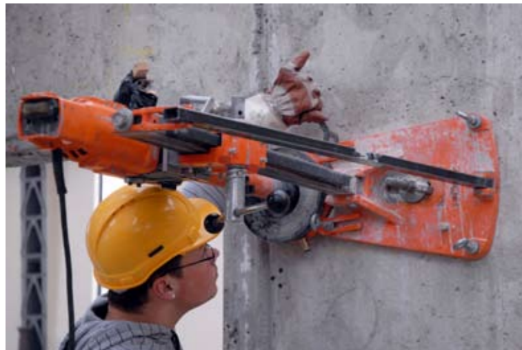
Setzen von Kernbohrungen
