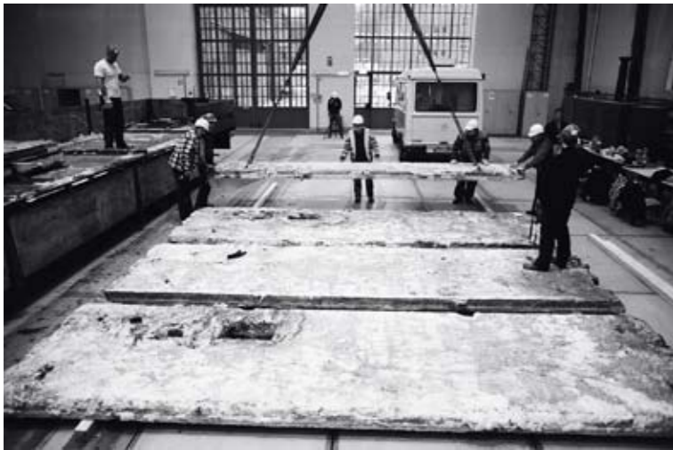
Anlieferung von Platten aus Frankfurt/Oder
